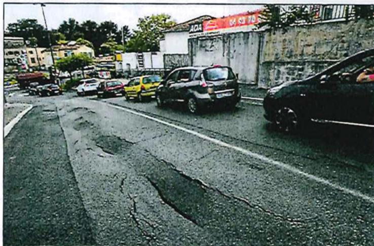
Suite à la rupture d'une canalisation d'eaux pluviales, l'avenue Sidi-Brahim, qui descend vers les Quatre-chemins, a été éventrée. (Photos A.B.-J.)
